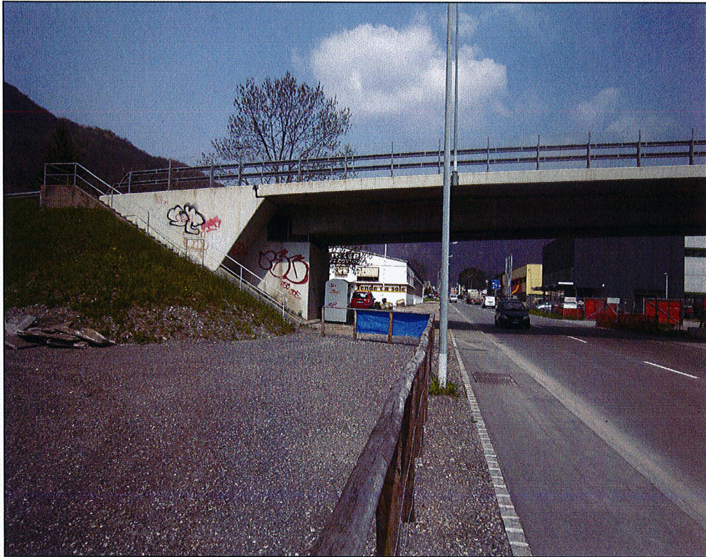
Spalla nordovest e scala pedonale
