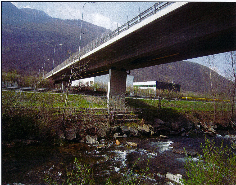
Vista generale del manufatto da sudest (lato sud)
